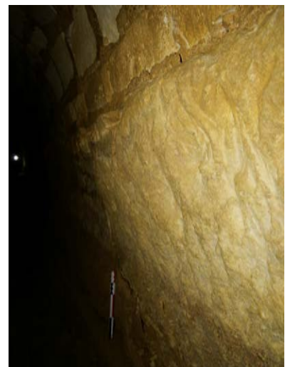
Figure 87 Bûchage de la paroi rocheuse pour surélever le conduit, section Torregrossa. © V. Mialhe (SahCM)
