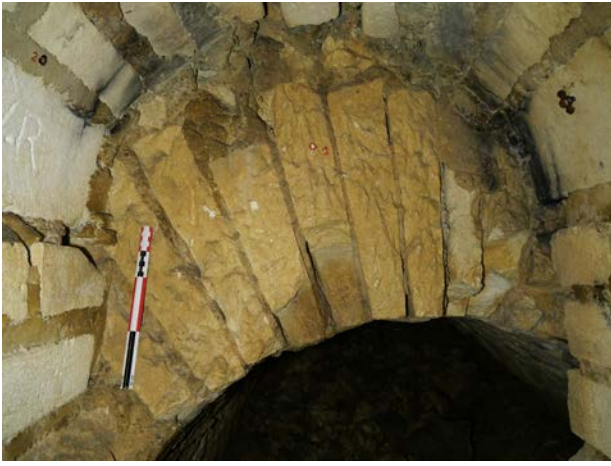
Figure 76 Exemple de la mise en forme des voûtes (V2002) lors de la phase I, vue vers le sud. © V. Mialhe (SahCM)
