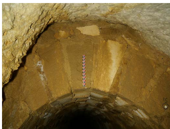
Figure 96 Claveaux constituant la voûte 1007, vue vers le sud. © V. Mialhe (SahCM)
