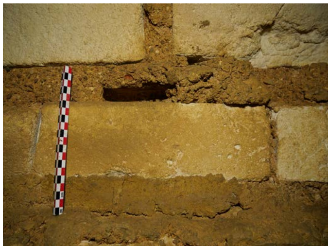
Figure 93 Négatif de planche du coffrage pour la construction de la voûte 1007. © V. Mialhe (SahCM)
