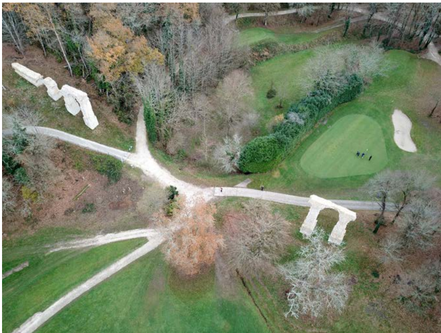
Figure 3 Les cinq piles et la culée amont du pont des Arcs après la restauration, vue vers le nord-ouest.
