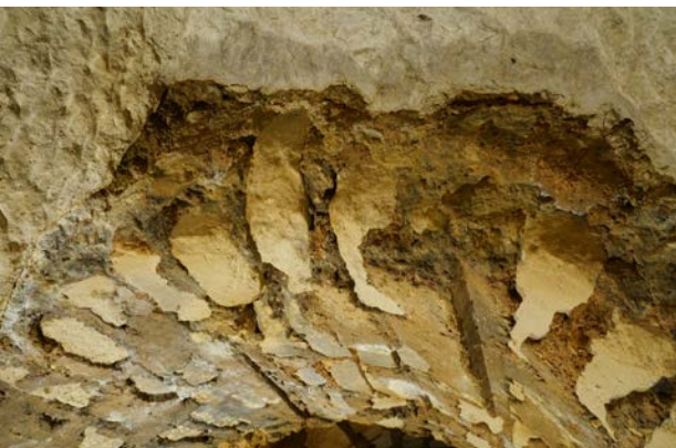
Figure 79 Négatifs de planches sur le pourtour de la voûte. © V. Mialhe (SahCM)
