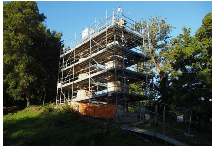
Figure 22 Échafaudage des piles 14 à 15, vue vers le sud-ouest.
