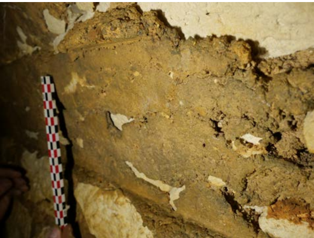
Figure 78 Négatif d'une planche du coffrage de la voûte 1014 lors de la phase I, vue vers le sud-ouest. © V. Mialhe (SahCM)
