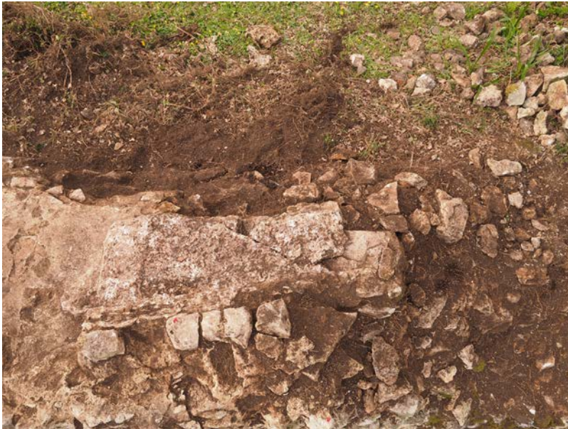
Figure 59 Négatif d'empreinte sur le tablier de la culée aval. © V. Miaillhe (SahCM)
