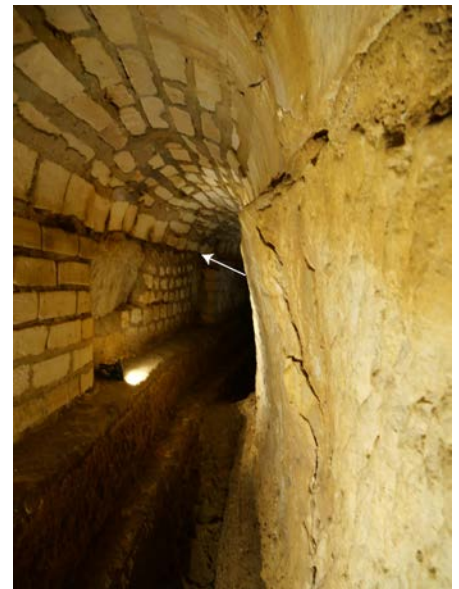
Figure 92 Changement d'appareillage dans les sommiers de la voûte 1016, vue vers le nord. © V. Mialhe (SahCM)
