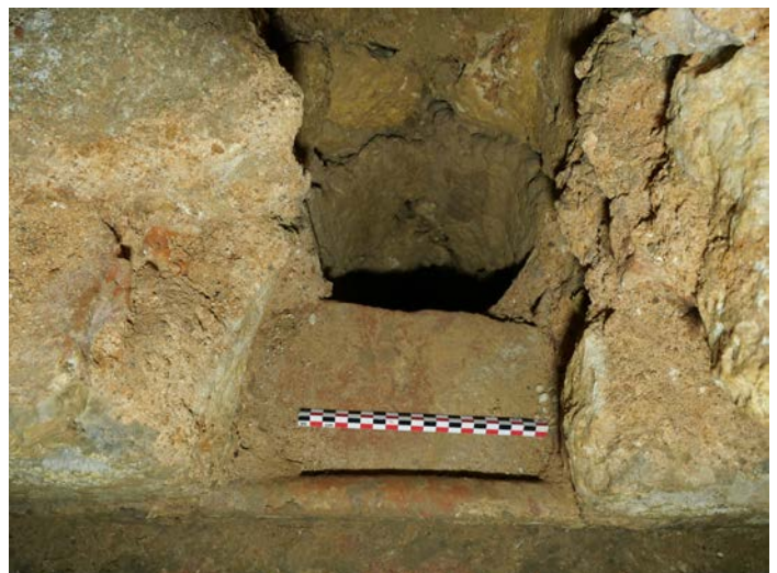
Figure 82 Conduit d'évacuation 1011, vue vers l'est. © J.-L. Hillairet (SahCM)
