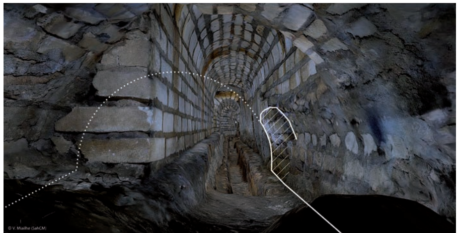
Figure 86 Bûchage de la voûte 1010 pour la mise en place de la voûte 1007 lors de la phase II (section Torregrossa), vue vers l'est. © V. Mialhe (SahCM)
