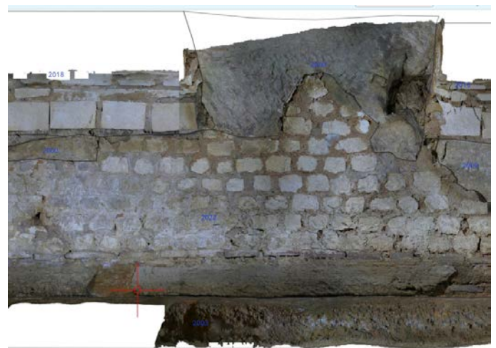
Figure 75 Assise de TCA sur la partie basse de la maçonnerie 2022. © V. Mialhe (SahCM)
