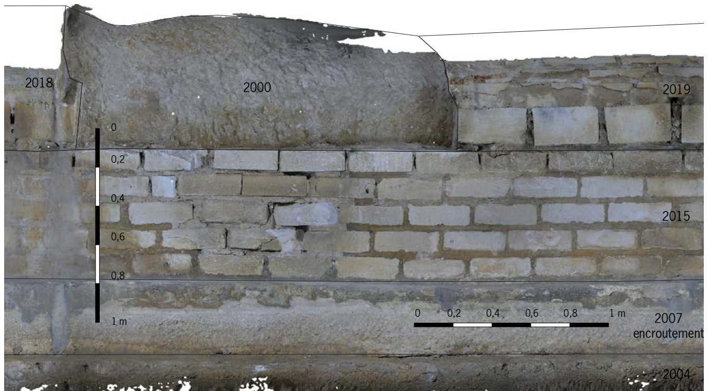
Figure 88 Orthophotographie de l'appareillage en opus quadratum de l'unité architecturale 2015.
