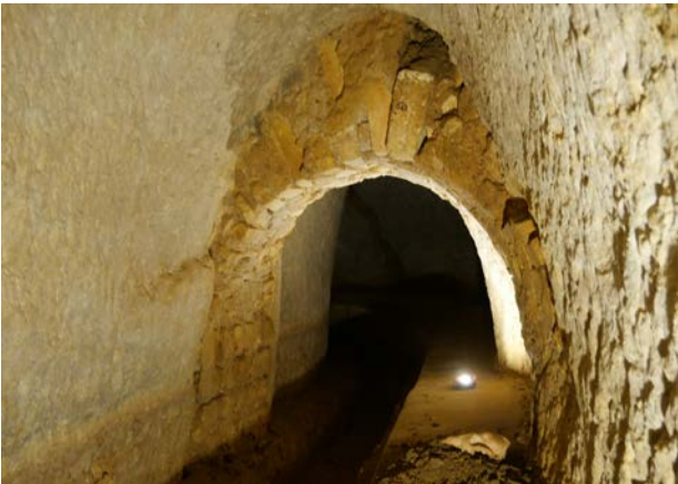
Figure 77 Exemple de la mise en forme des arcs de bouchage de diaclases (V1037) lors de la phase I, vue vers le sud-ouest. © V. Mialhe (SahCM)
