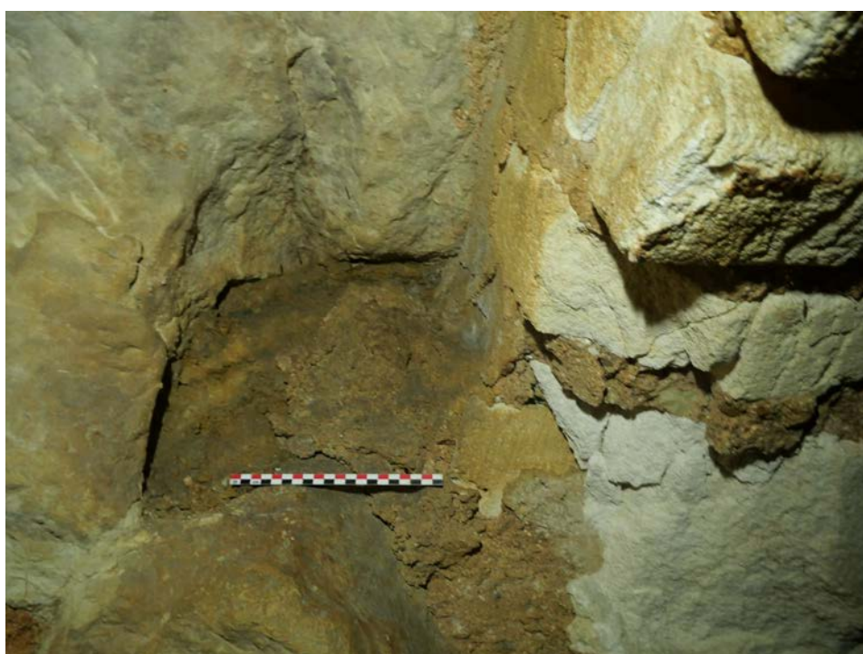
Figure 95 Joint débordant à la base du sommier de la voûte 1007. © V. Mialhe (SahCM)
