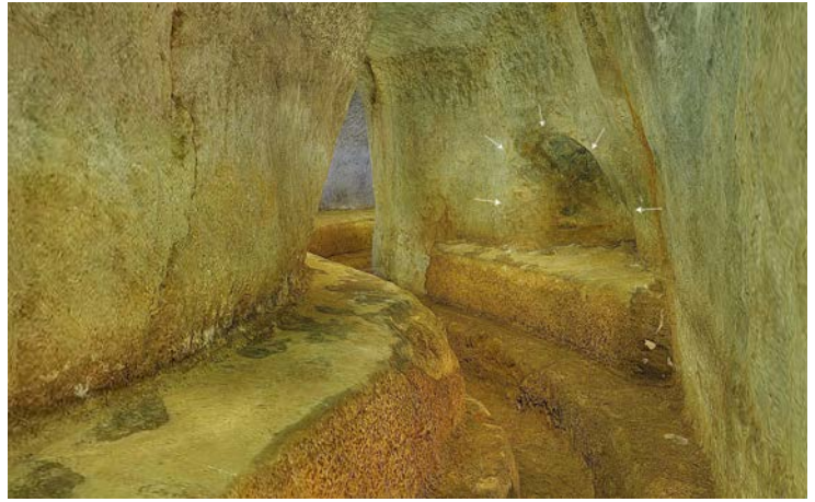
Figure 73 Chicane dans le tunnel de Torregrossa et marquage de l'arrêt des tunneliers, vue vers le nord. © V. Mialhe (SahCM)
