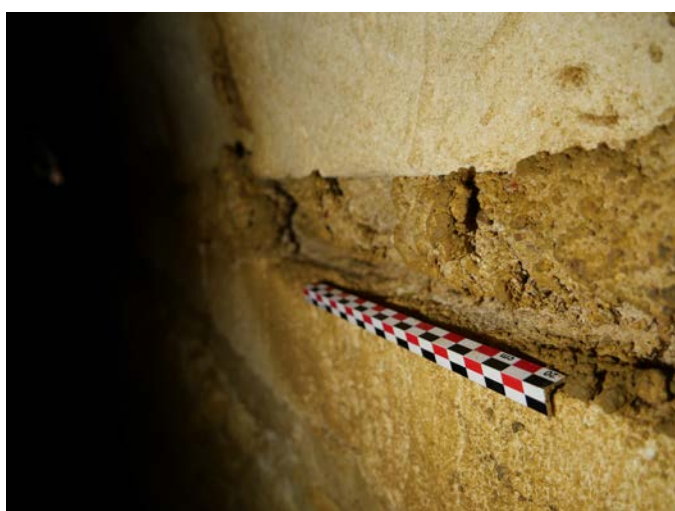
Figure 95 Joint débordant à la base du sommier de la voûte 1007. © V. Mialhe (SahCM)
