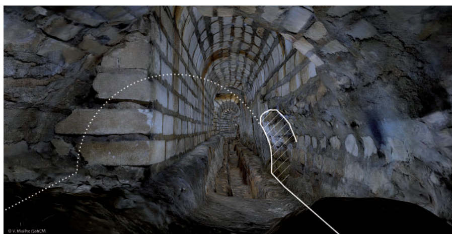
Figure 86 Bûchage de la voûte 1010 pour la mise en place de la voûte 1007 lors de la phase II (section Torregrossa), vue vers l'est. © V. Mialhe (SahCM)
