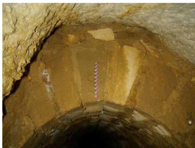
Figure 96 Claveaux constituant la voûte 1007, vue vers le sud. © V. Mialhe (SahCM)
