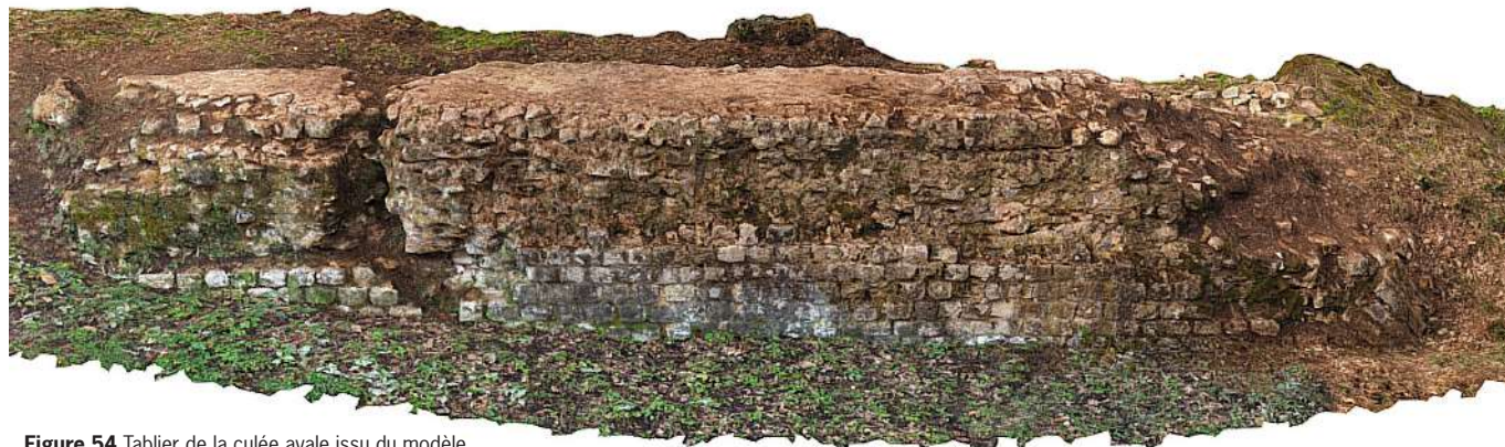
Figure 54 Tablier de la culée aval issue du modèle 3D, vue vers l'ouest. © V. Mialhe (SahCM)
