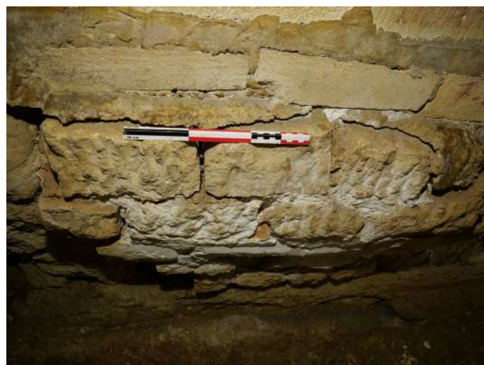
Figure 86 Bûchage de la voûte 1010 pour la mise en place de la voûte 1007 lors de la phase II (section Torregrossa), vue vers l'est. © V. Mialhe (SahCM)
