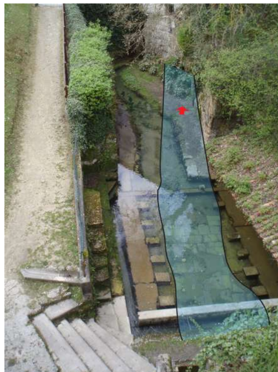
Figure 41 Source de Vènerand au lieu-dit « Fontaines Romaines » et son lavoir XVIII e siècle, vue vers le nord-ouest. © J.-L. Hillairet (SahCM)
