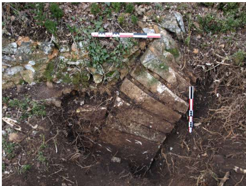
Figure 57 Départ de l'arche sur la culée aval, vue vers l'ouest. © V. Mialhe (SahCM)
