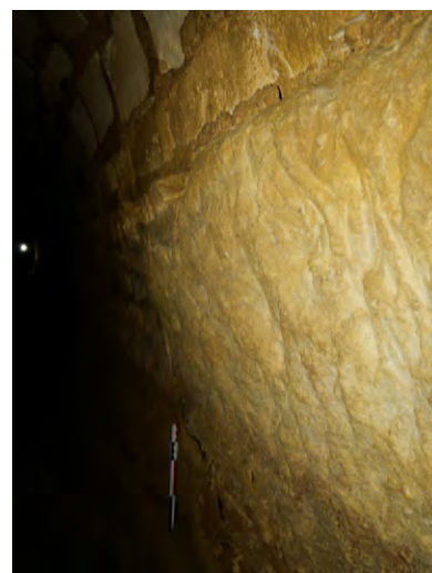
Figure 87 Bûchage de la paroi rocheuse pour surélever le conduit, section Torregrossa.
