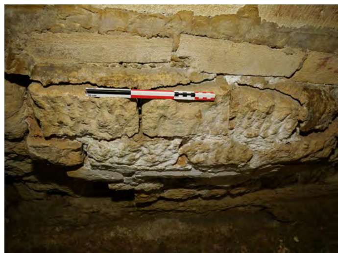
Figure 86 Bûchage de la voûte 1010 pour la mise en place de la voûte 1007 lors de la phase II (section Torregrossa), vue vers l'est.
