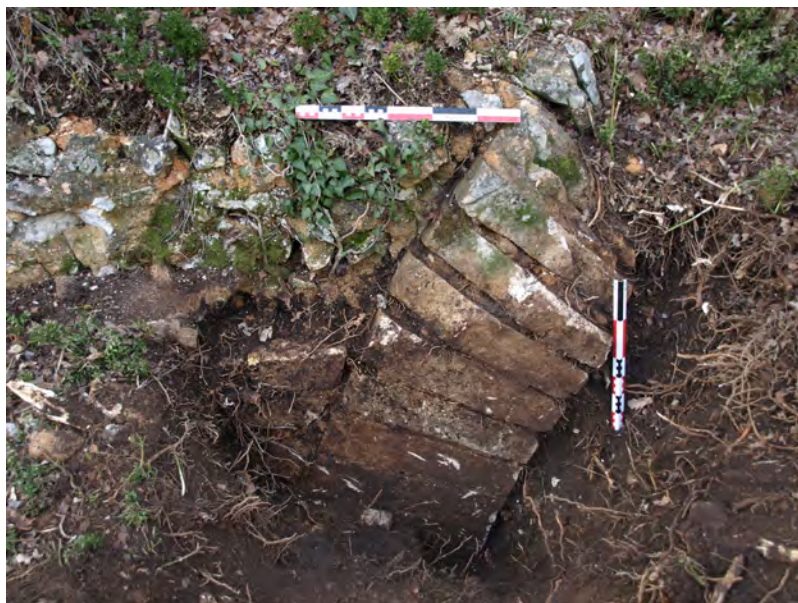
Figure 57 Départ de l'arche sur la culée aval, vue vers l'ouest. © V. Mialthe (SahCM)
