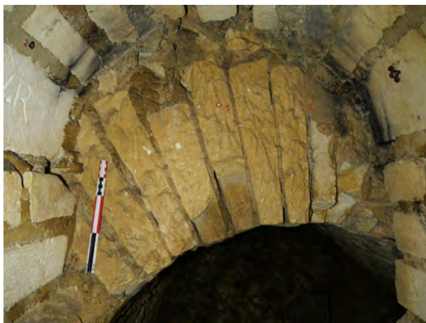
Figure 76 Exemple de la mise en forme des voûtes (V2002) lors de la phase I, vue vers le sud. © V. Mialhe (SahCM)
