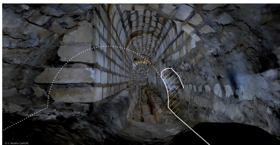
Figure 86 Bûchage de la voûte 1010 pour la mise en place de la voûte 1007 lors de la phase II (section Torregrossa), vue vers l'est.
