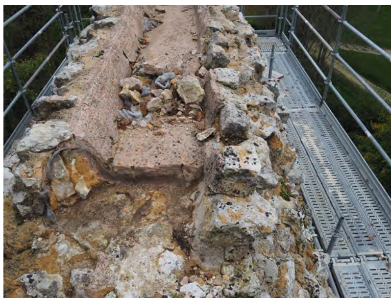
Figure 58 Restauration du conduit posée sur un géotextile et dessous, ancienne maçonnerie pouvant correspondre au canal de la phase III, vue vers le sud. © V. Mialthe (SahCM)
