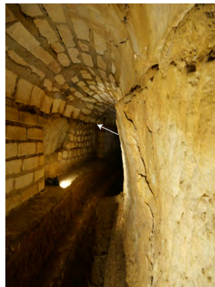
Figure 92 Changement d'appareillage dans les sommiers de la voûte 1016, vue vers le nord. © V. Mialhe (SahCM)
