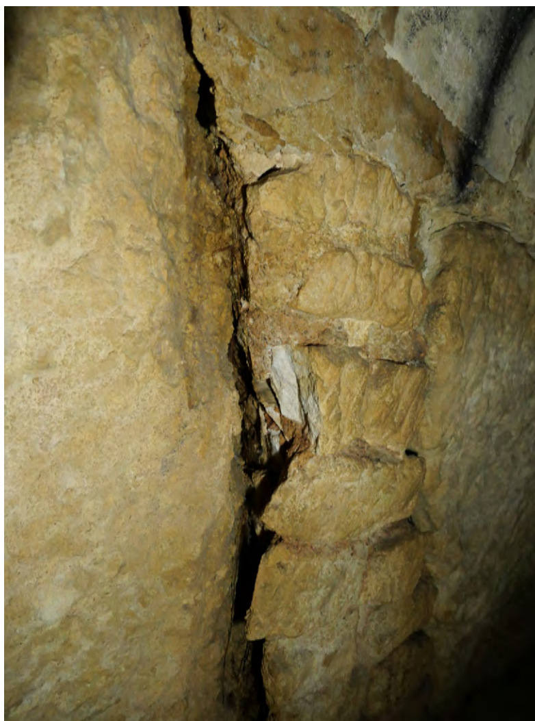
Figure 98 Le détachement de la maçonnerie 2013, scellant une diaclase, vue vers le sud-est. © V. Miaillhe (SahCM)
