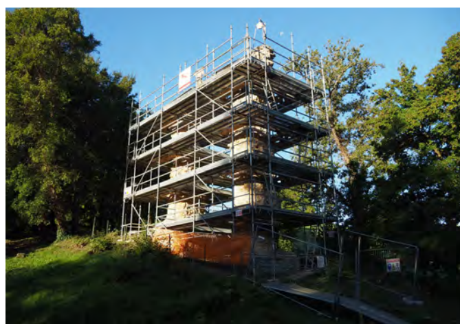
Figure 22 Échafaudage des piles 14 à 15, vue vers le sud-ouest.
