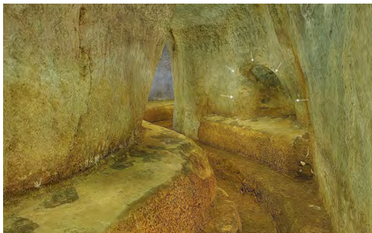
Figure 73 Chicane dans le tunnel de Torregrossa et marquage de l'arrêt des tunneliers, vue vers le nord. © V. Mialhe (SahCM)
