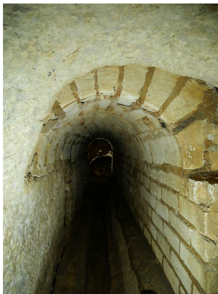
Figure 90 Voûte 2010, vers le sud. © V. Mialhe (SahCM)
