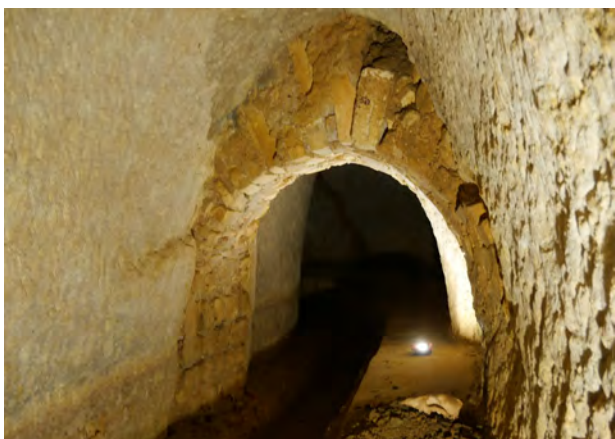
Figure 77 Exemple de la mise en forme des arcs de bouchage de diaclasses (V1037) lors de la phase I, vue vers le sud-ouest. © V. Mialhe (SahCM)
