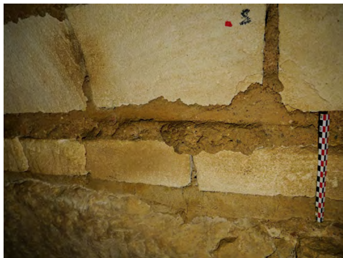
Figure 94 Négatif de planche correspondant à la base du vau, sous les sommiers de la voûte 1007. © V. Mialhe (SahCM)
