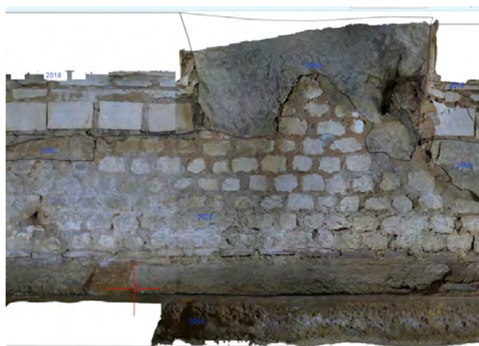
Figure 75 Assise de TCA sur la partie basse de la maçonnerie 2022. © V. Mialhe (SahCM)
